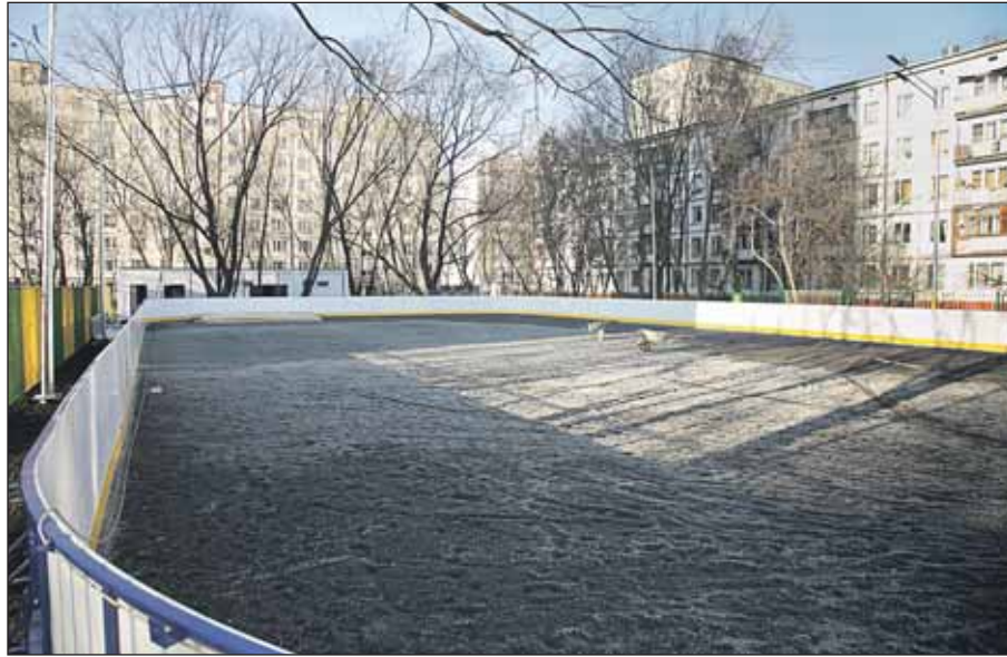
Строительство катка закончится уже в декабре
