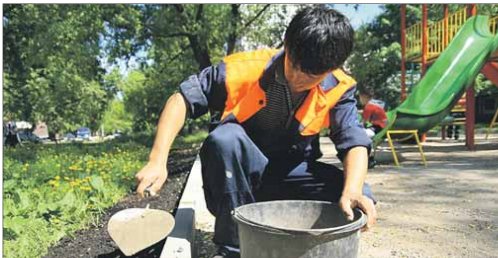
Благоустройство на улице Инженерной, 11
