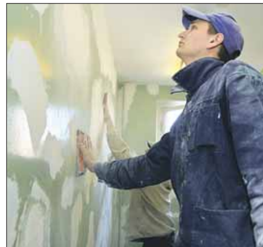
Ремонт на Путевом проезде, 14, корп. 1
